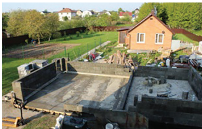
Рисунок 15. Строительство дома (Минская обл.)
