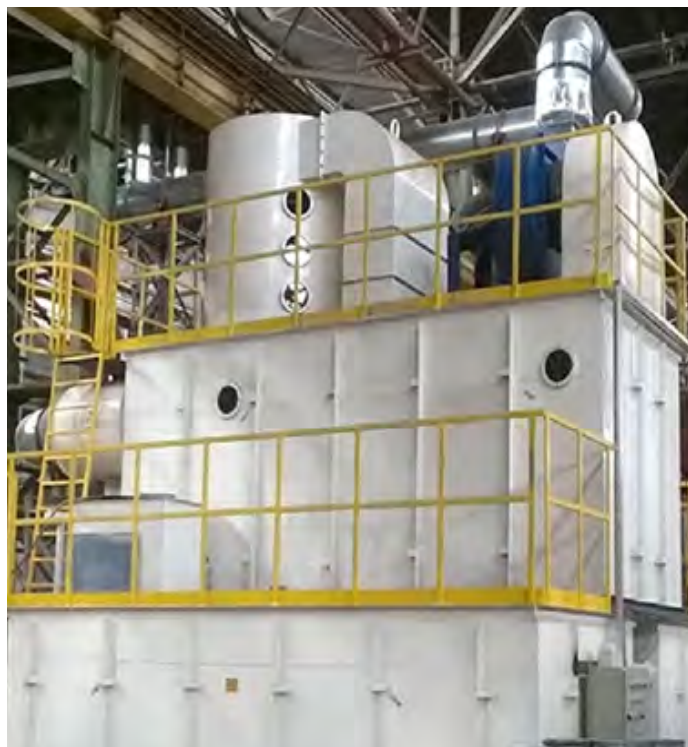
Рисунок 3 - Общий вид. АБХУ ООО «Техпромлит» РФ. АБХУ очистки вентиляционного воздуха от триэтиламина. Производительность по вентвоздуху 20 000 м³/ч
