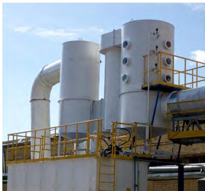
Рисунок 2 - Общий вид АБХУ. ЗАО «Красный якорь» РФ. АБХУ очистки вентиляционного воздуха от фенола, формальдегида. Производительность по вентвоздуху 30 000 м³/ч
