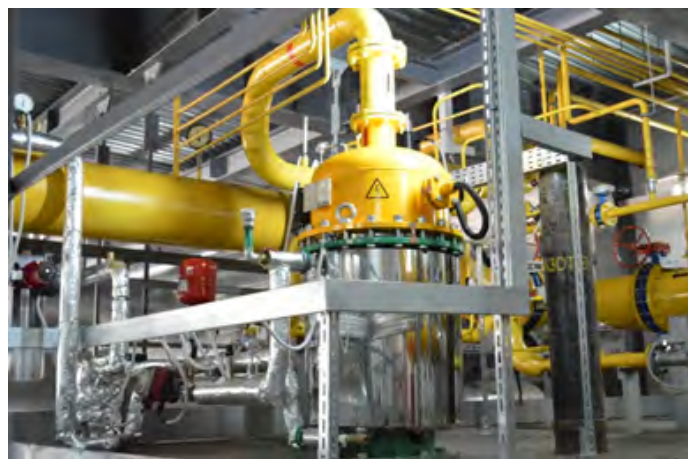
Рисунок 2 - Установка ТГУ-15-6-Н на Мину-ТЭЦ
