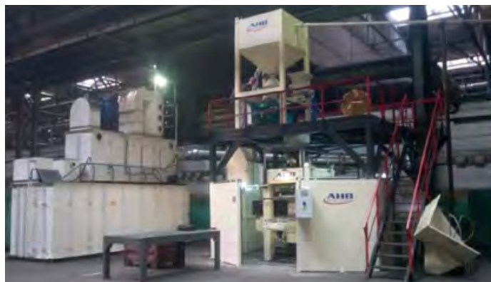
Рисунок 4 - Общий вид. АБХУ РУП «ГЗЛиН» РБ. АБХУ очистки вентиляционного воздуха от триэтиламина. Производительность по вентвоздуху 10 000 м³/ч
